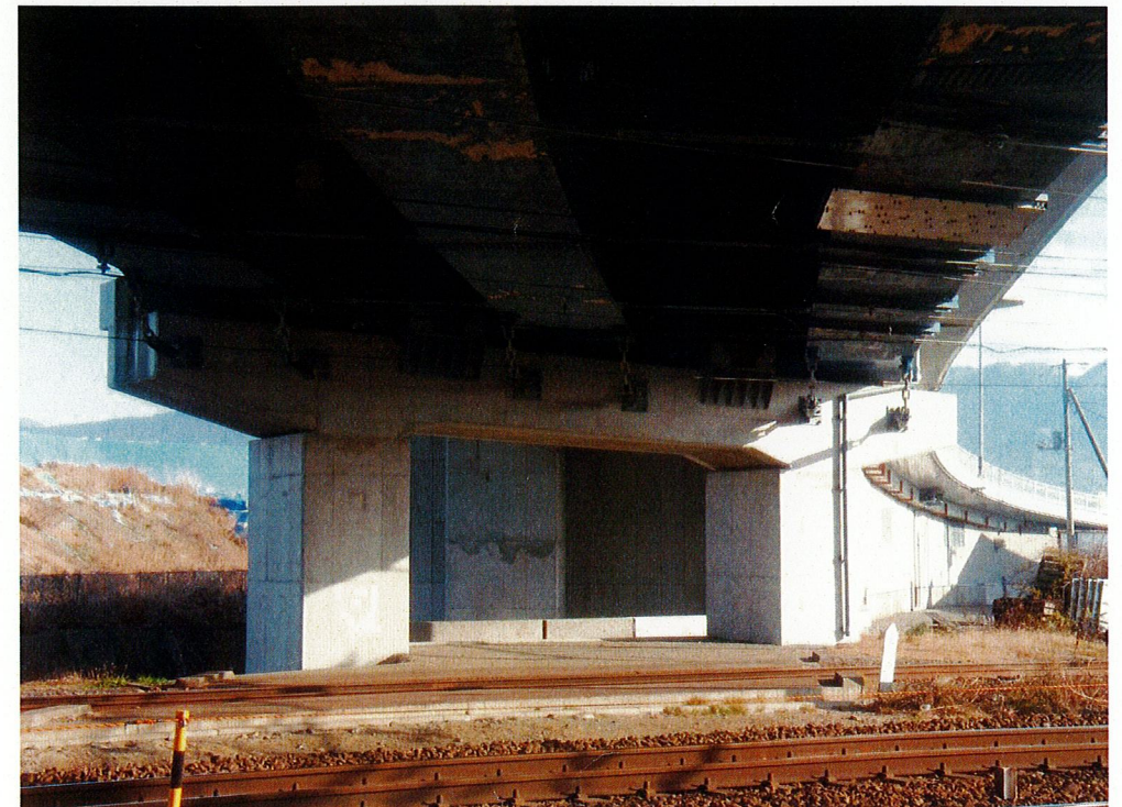
耐震補強状況（P 6 橋脚）
